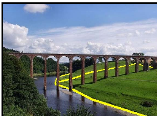
Figura J-37 – Prédio delimitado sob obra de arte
