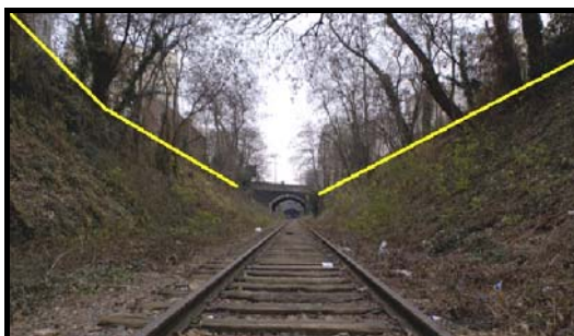
Figura J-16 – Prédios delimitados juntos a via ferroviária em zona com declive
