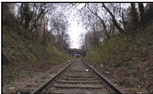
Figura J-15 – Via ferroviária em zona com declive
