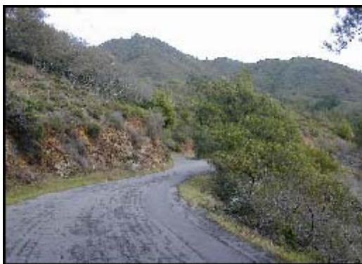
Figura J-11 – Via rodoviária em zona com declive
